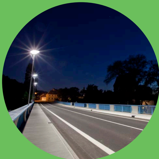
osvětlení komunikací a parků Brandýs nad Labem
